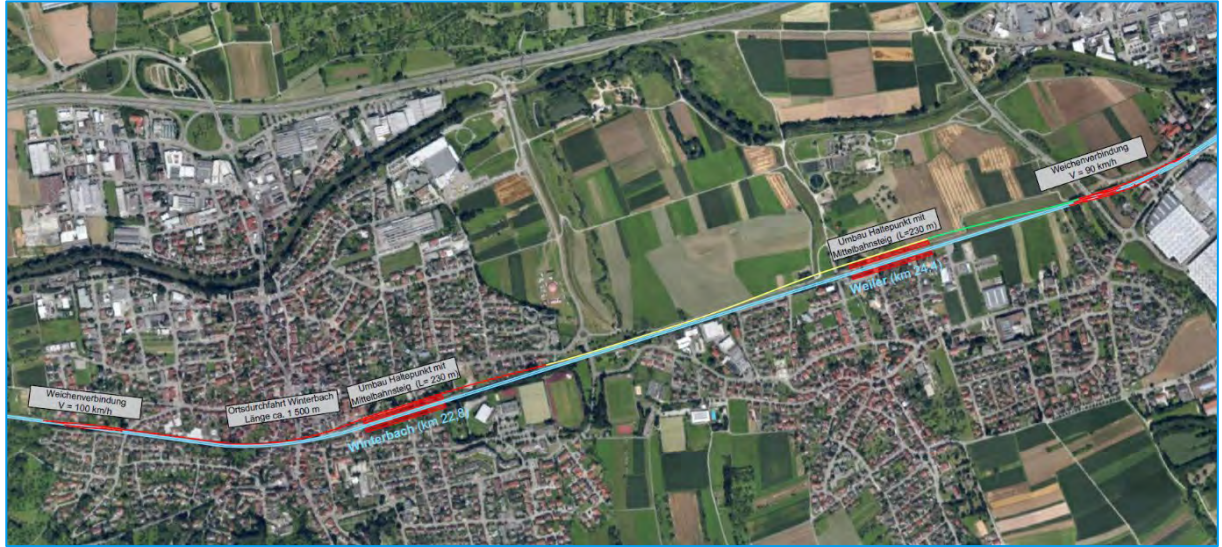
Abbildung 71: Dreigleisiger Ausbau Winterbach – Schorndorf
