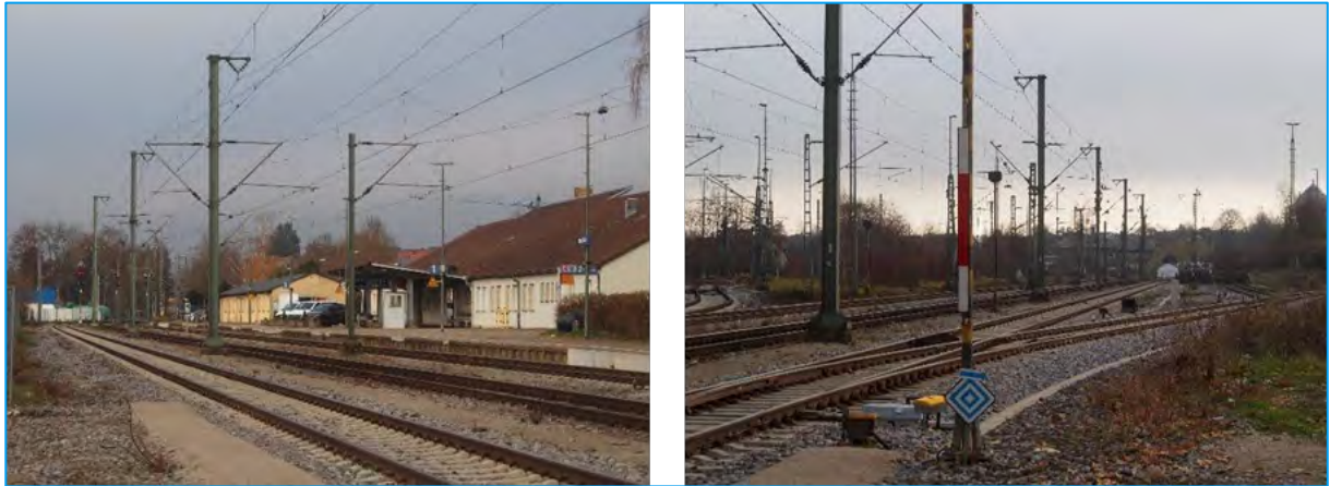
Abbildung 66: Bestandssituation Bf. Crailsheim (Foto 2020)
