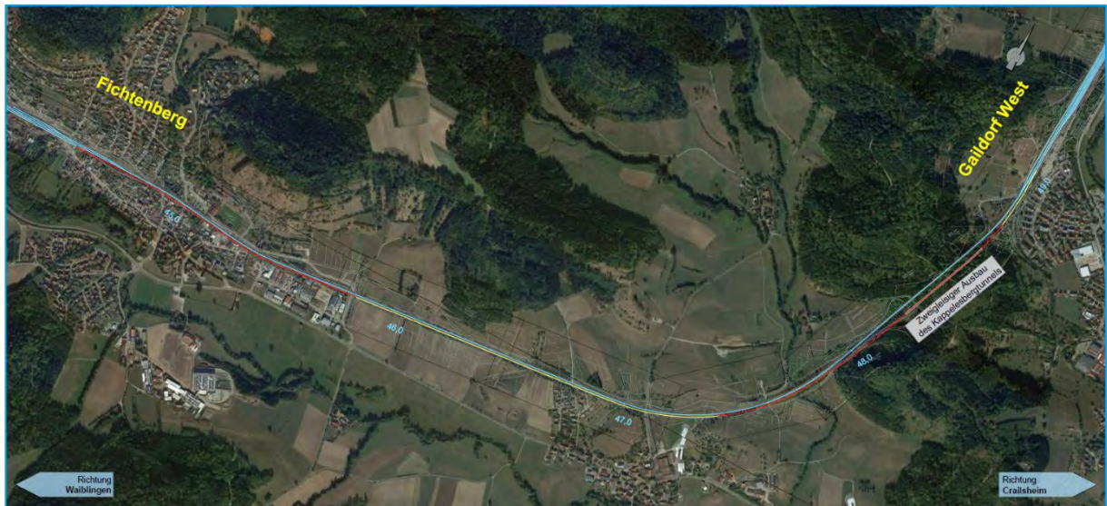
Abbildung 62: Zweigleisiger Ausbau Fornsbach - Gaildorf West (Abschnitt Fichtenberg – Gaildorf West)
