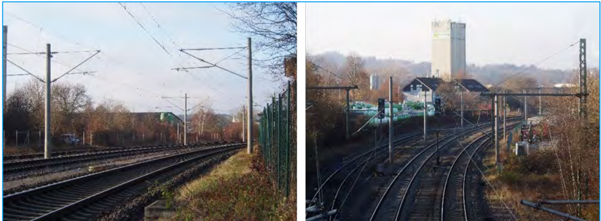
Abbildung 68: Bahnhof Sulzdorf – Istzustand (Foto 2020)
