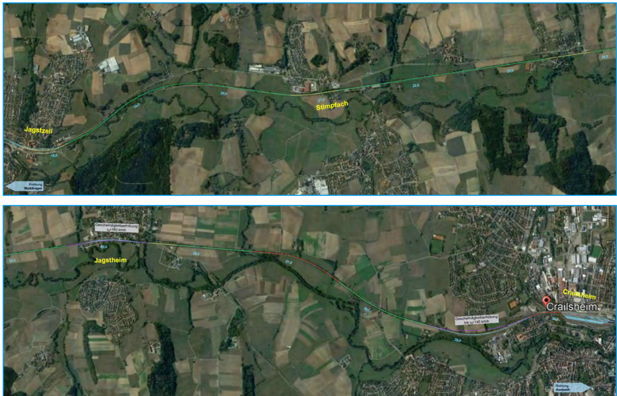
Abbildung 77: Ertüchtigung Jagstzell – Crailsheim auf 160 km/h
