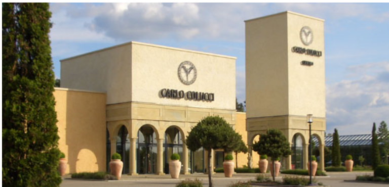
Bild: Bestehender Direktverkauf der Fa. Carlo Colucci im Gewerbegebiet Regmannsdorf im mediterranen Stil.
